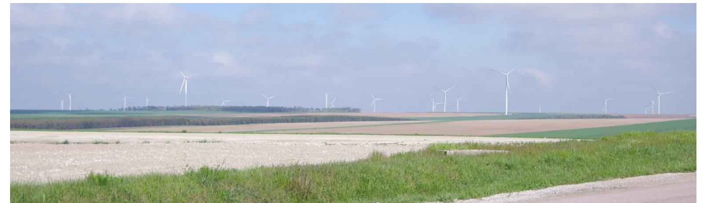
Photo 36 : Éoliennes présentes au Nord de la vallée de l'Aube (Source : RESONANCE)
