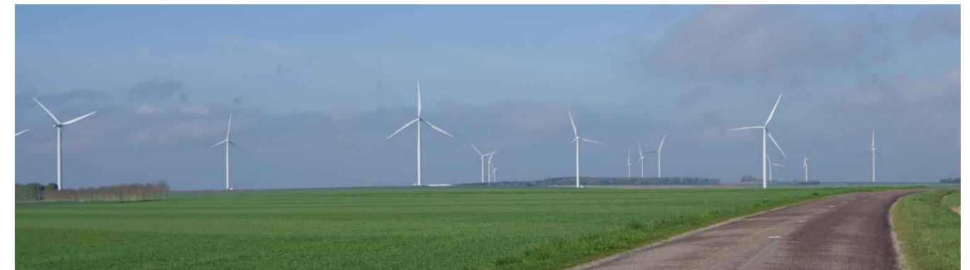
Photo 35 : Éoliennes aux abords de Premierfait (Source : RESONANCE)
