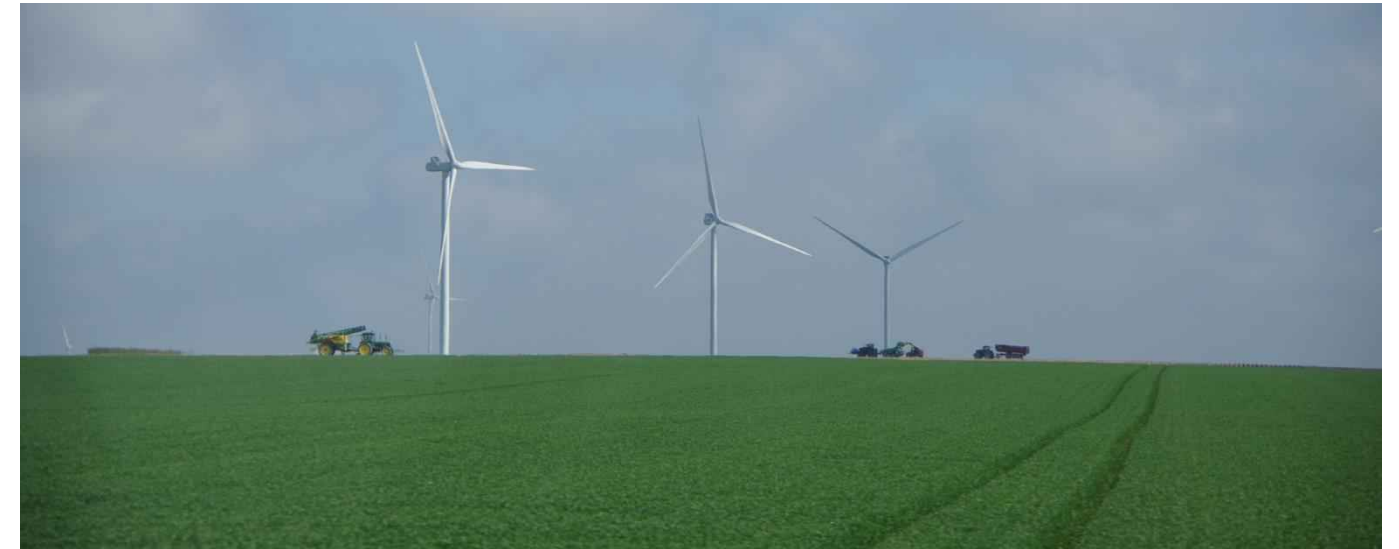
Photo 24 : Parc éolien aux abords de Viâpres-le-Petit (D56) (Source : RESONANCE)
